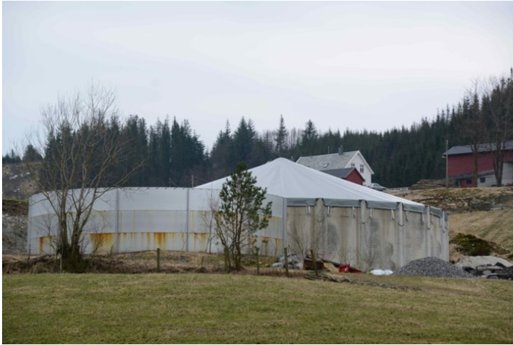
Gjødsellager med og utan tak Foto: Sveinung Klyve.
