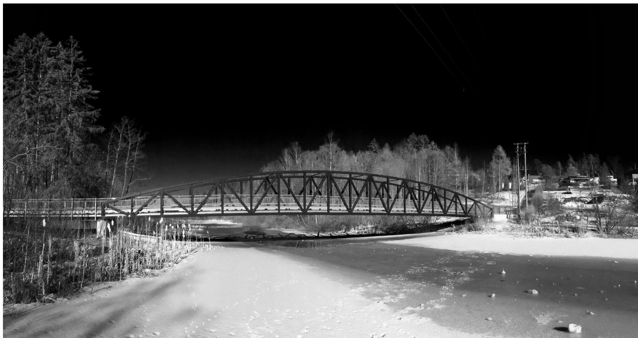
Figur 4.3: Eksempel på fagverksbru i stål (Bondi gang- og sykkelbru, Asker).
