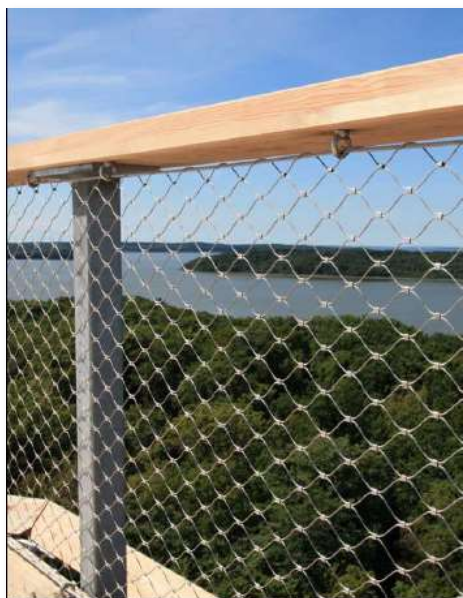
Figur 4.8: Mulig rekkverk av wirenetting.
