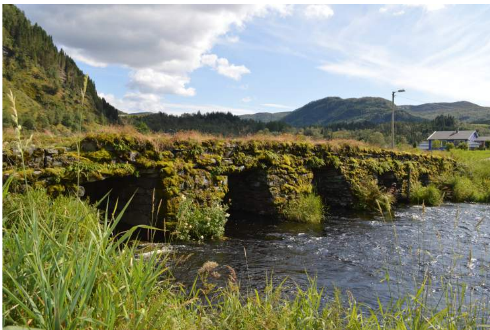
Hålandsbrua på Den trondhjemske postvegen
