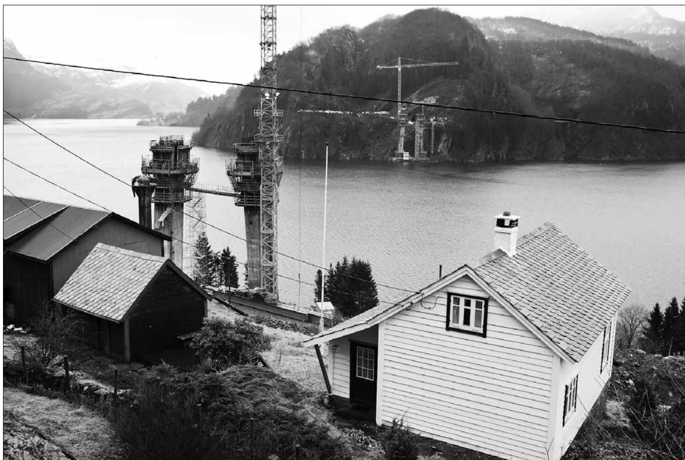
Brubygging sett frå Ottersteinen. Foto: Bent Are Iversen/FIRDA
