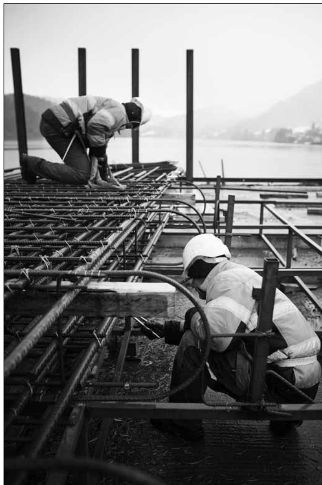
Jarnbinding på Dalsfjordbrua. Foto: Bent Are Iversen/FIRDA
